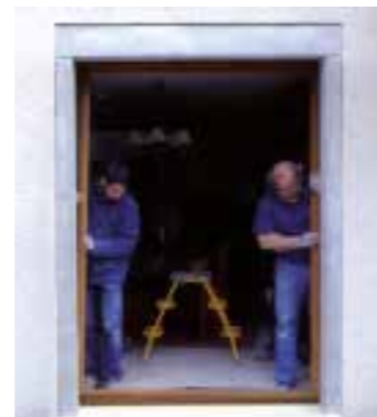
Pose de la nouvelle menuiserie
