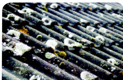
1. Tuiles avant les travaux.
