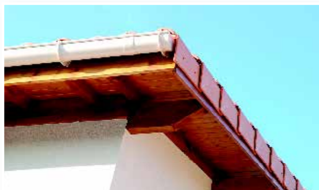
Débord de toit en bois
