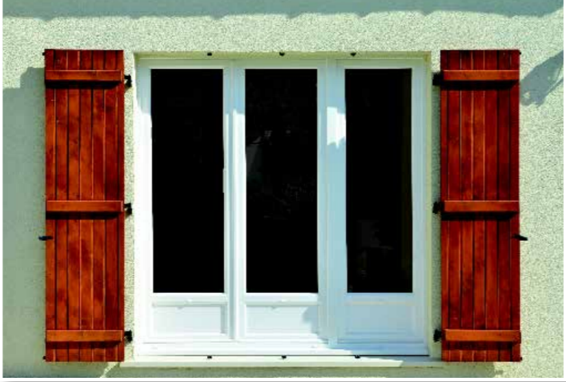
Porte-fenêtre ouvrante avec vantail fixe
