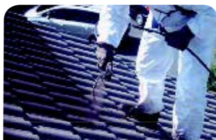
4. Recoloration au pistolet en deux passes.
