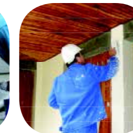
Application enduit de finition
