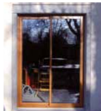
Pose des ouvrants
