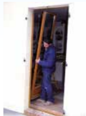
Dépose de l'ancienne menuiserie
