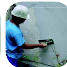
Application enduit de ragréage
