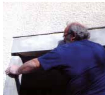
Pose des ébrasements en béton
