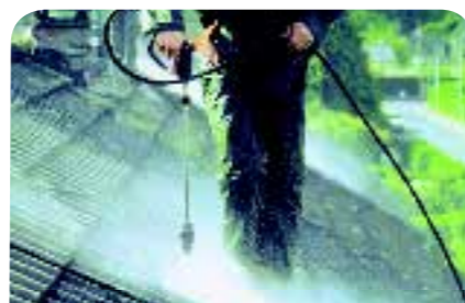
2. Nettoyage, démoussage et décapage haute pression.
