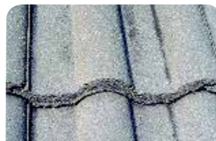
3. Aspect des tuiles après le nettoyage.
