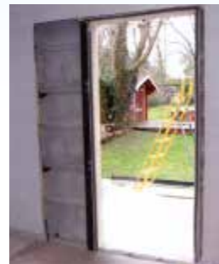
Dépose de la cloison et de l'isolation
